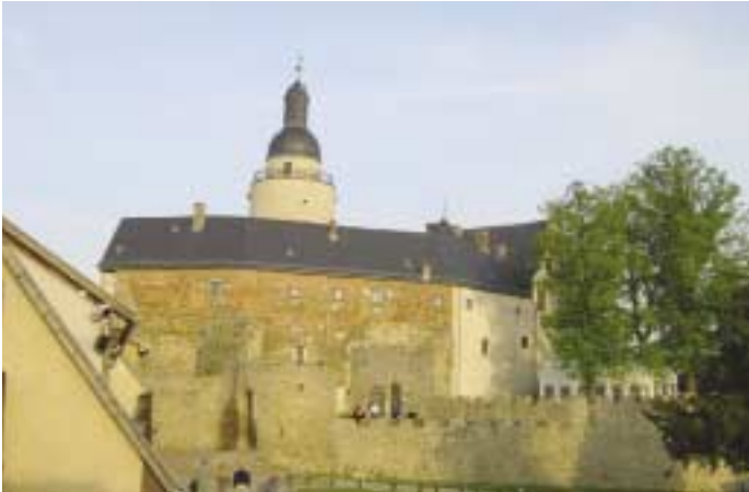
Blick auf die Burg Falkenstein. Auf einem Bergsporn über dem Selketal gelegen entstand diese Burg zwischen 1115 und 1120. Bauherr war Burchard d. J. von der Konradsburg, seit 1120 genannt, Herr von Falkenstein.
